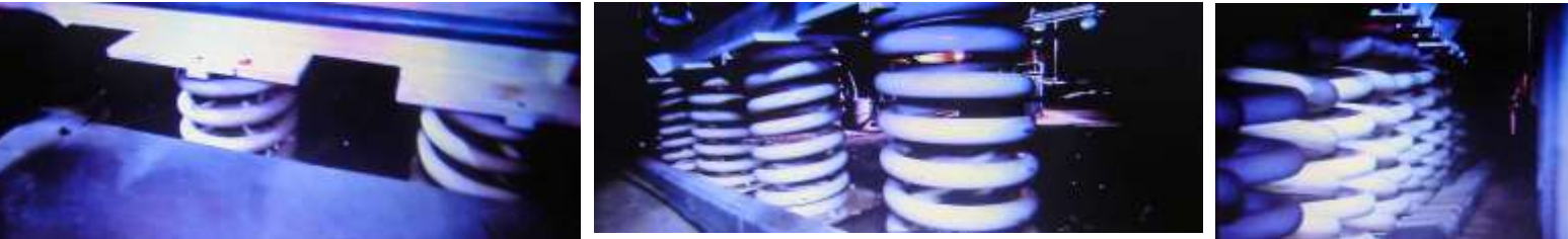
Cheyennebunkern har över 1300 sådana här fjädrar under byggnaderna
