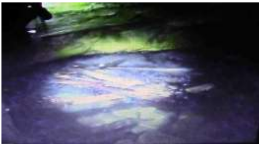
Tredje nivån, våningen är fylld med vatten.
